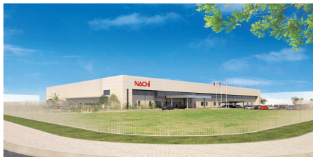
NACHI TECHNOLOGY MEXICO S.A. DE C.V. (2015年12月竣工予定)
