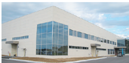
油圧モータ工場 (建設機械用油圧機器の組立工程を自動化)
