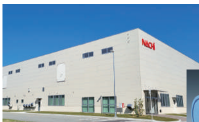
油圧走行モータ新工場
