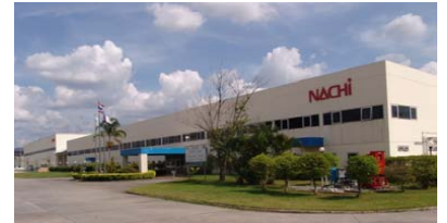
タイ第3工場 新設
