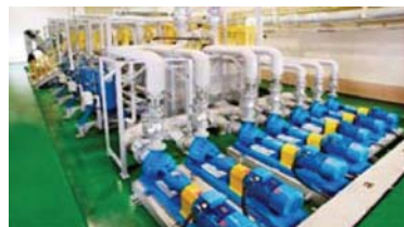
加工液フィルトレーション(リサイクル)システム
