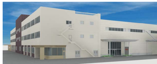
ロボット第3工場
